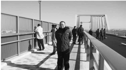
東京ゲートブリッジ
