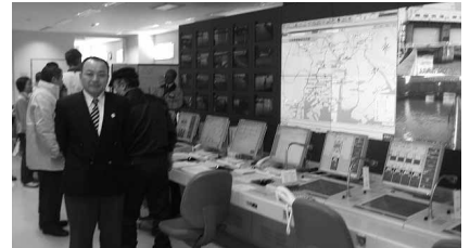
東京都江東治水 事務所水門管理センター
